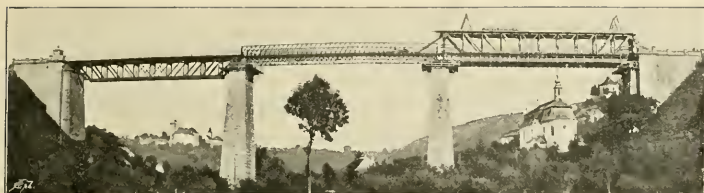
Abb. 169. Viaduct Stranov während der Auswechslung.
